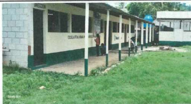
Foto 2: se realizará la nivelacion del corredor e instalación de piso cerámico
