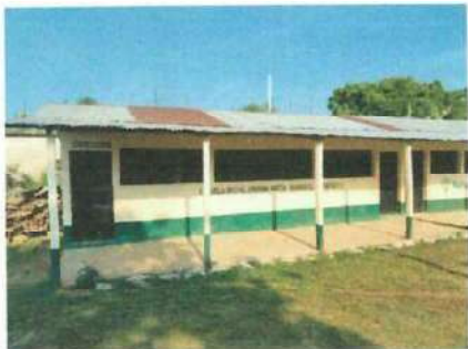
Foto1: se cambiará los postes de madera por bases de concreto
